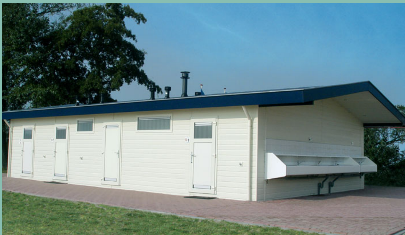
Houtskeletbouw sanitair paviljoen, binnenzijde tegelwerk en buitenzijde bekleed met canexel
