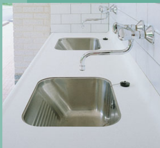
Achteropstand in tegelwerk
