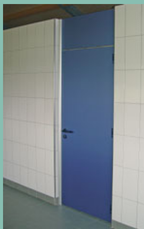
Deur technische ruimte
